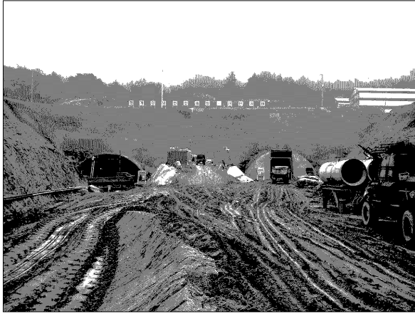
<사진 1> 정개터널 시점 시공전경
