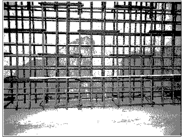
[정개터널]콘크리트 라이닝 철근 배근간격 측정 광경(주철근 C.T.C 150mm)
