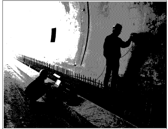
<봉현터널 성남방향> 터널내부 라이닝 콘크리트 철근배근 탐사시험
