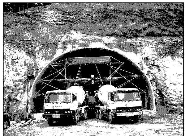
<사진 6> 봉현터널 STA. 1+898~907 라이닝 콘크리트 타설전경(하행선)
