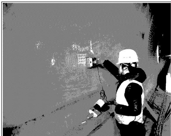
[정개터널] 전자파 레이더법에 의한 철근탐사시험 광경
