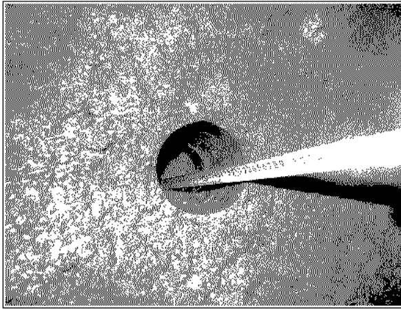
[정개터널]숏크리트 두께 측정 광경
