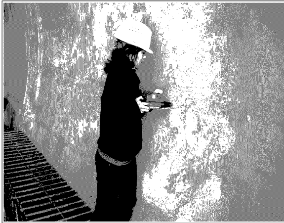
<봉현터널 성남방향> 터널내부 라이닝 콘크리트 강도시험
