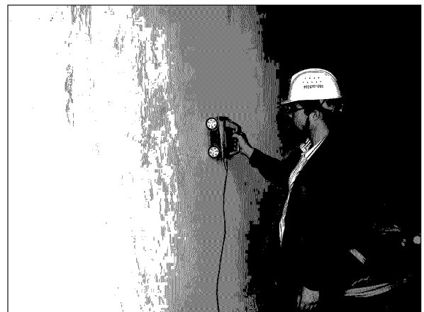
<사진 12> 봉현터널(상행선) 라이닝 철근배근 상태조사
