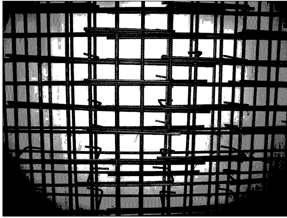
<사진 7> 봉현터널 측벽 철근배근 상태(하행선)
