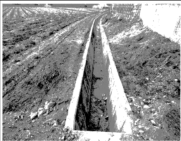
중점 배수로 전경
